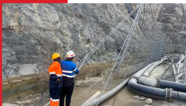
Frontier Mine, RXE barrier
